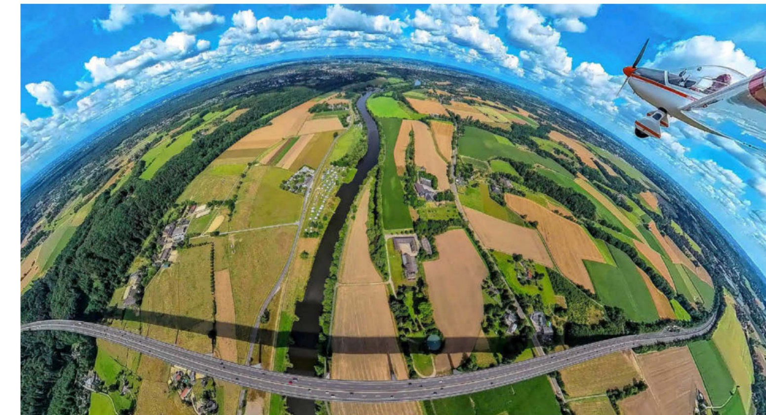
Die Mülheimer Ruhrtalbrücke der Autobahn A52 ist mit 1830 Metern die längste deutsche Straßenbrücke aus Stahl in Deutschland. Ihre Tage sind gezählt, sie ist dem Abriss geweiht.
