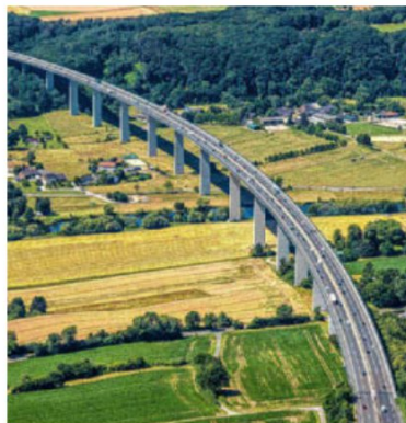
Ihre Tage sind gezählt: Die Ruhrthalbrücke der A52 in Mülheim wird neu gebaut.
