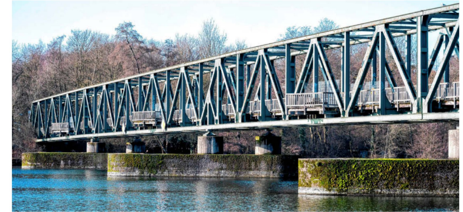
Seit 1984 ist das Bauwerk über den Baldeneysee eine Freizeitbrücke, seit Januar 2026 ist sie für alle gesperrt.
