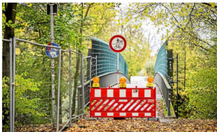
Der gesperrte Rad- und Fußweg über den Rhein-Herne-Kanal in Karnap zwingt Radfahrer zu langen und unbequemen Umwegen.
