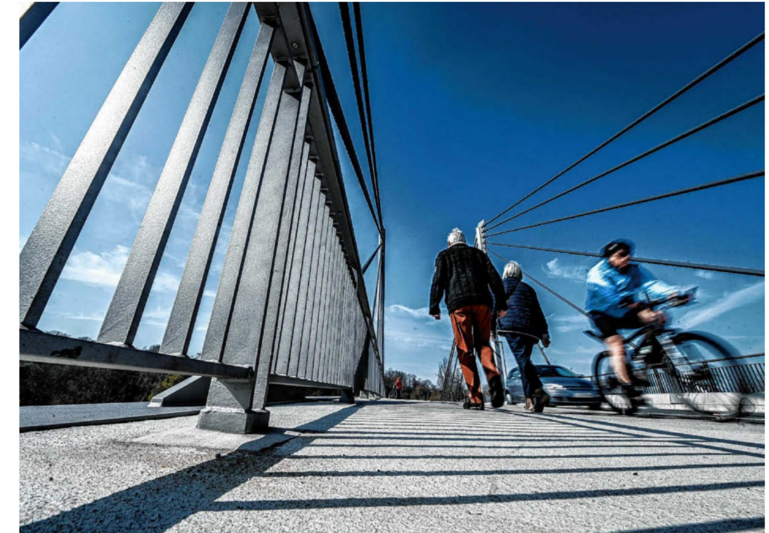
Autofahrer, Fußgänger und Radfahrer teilen sich die Kampmannbrücke, mit der Sperrung der früheren Eisenbahnbrücke ist es hier bei gutem Wetter voll und kann auch gefährlich werden, fürchten manche.
