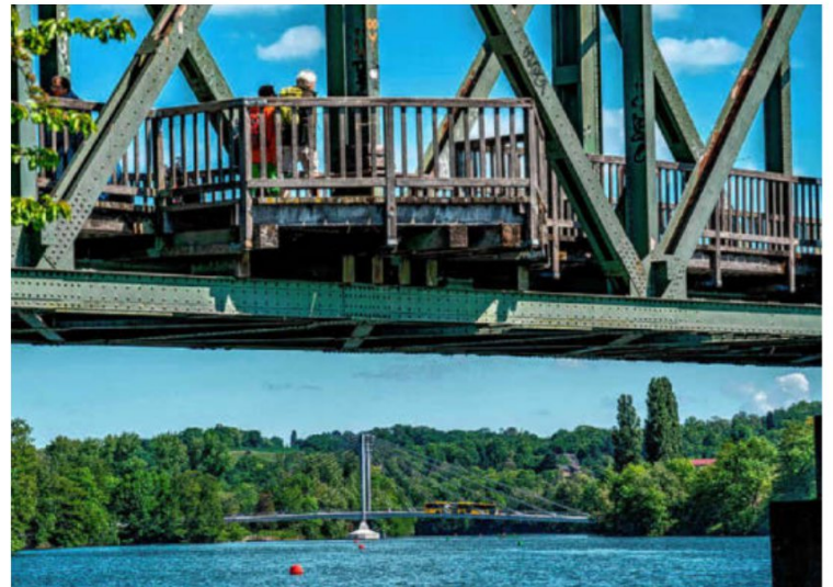
So sehen die Kanzeln auf der früheren Eisenbahnbrücke aus, die neuen Aussichtsplattformen werden flacher sein.
